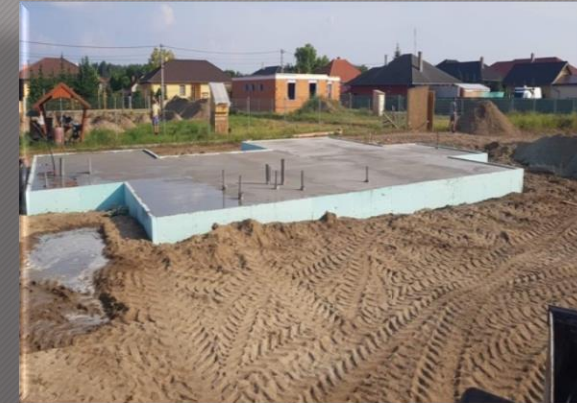
Szerelőbetonozás
