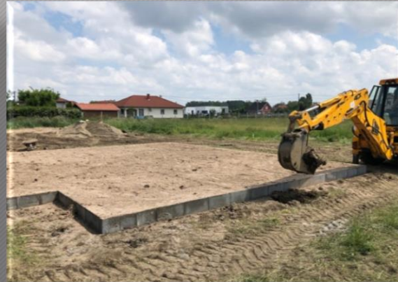
Lábazati zsalukő építése
